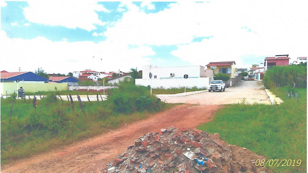
IMAGEM 02: INÍCIO DA PAVIMENTAÇÃO, CRUZAMENTO DA TRAVESSA MARIA MAFALDO DE OLIVEIRA SALES COM A RUA ODALEIA SOBREIRA PINTO
