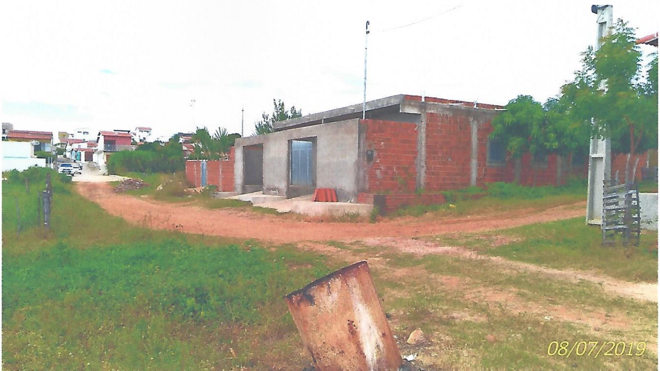
IMAGEM 03: FINAL DA PAVIMENTAÇÃO DA TRAVESSA MARIA MAFALDO DE OLIVEIRA SALES
