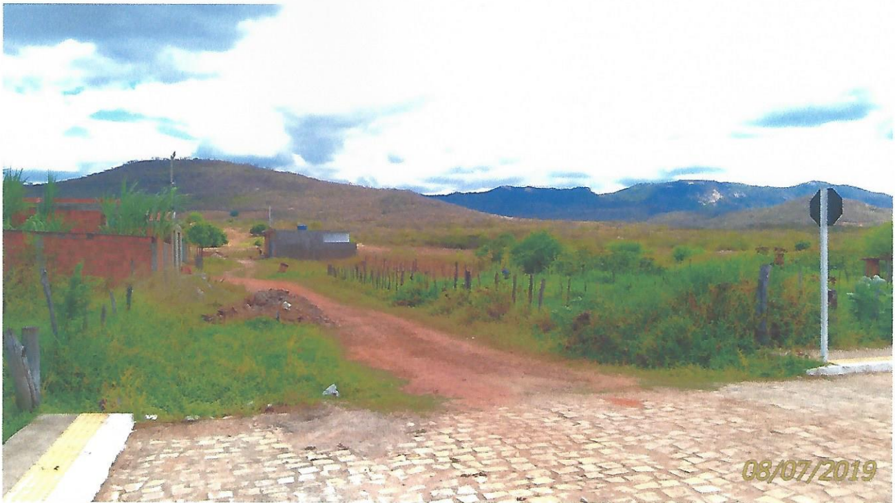
IMAGEM 01: INÍCIO DA PAVIMENTAÇÃO, CRUZAMENTO DA TRAVESSA MARIA MAFALDO DE OLIVEIRA SALES COM A RUA ODALEIA SOBREIRA PINTO.
