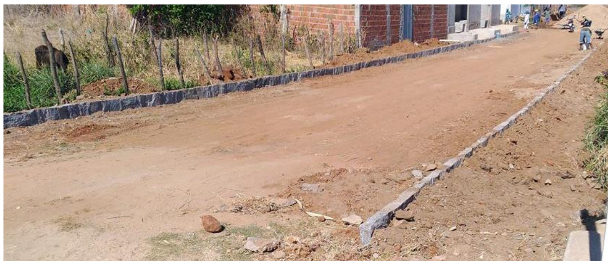
IMAGEM 03: EXECUÇÃO DE MEIO-FIO
