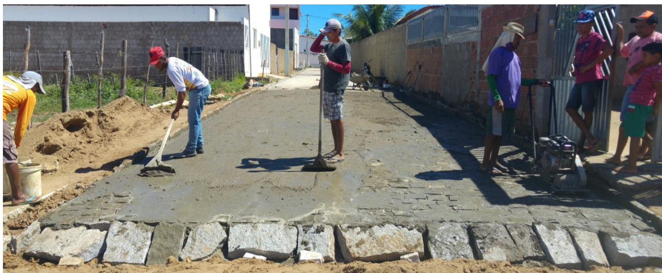
IMAGEM 07: COMPACTAÇÃO MANUAL DO PAVIMENTO
