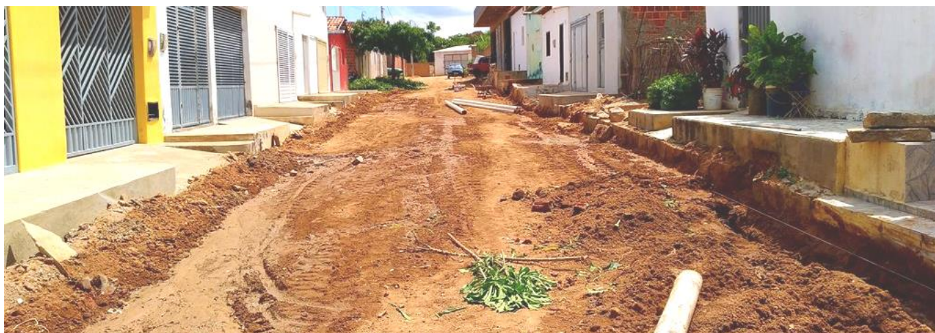
IMAGEM 02: TERRENO COM TERRAPLANAGEM EXECUTADA
