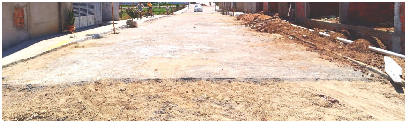
IMAGEM 08: TRAVAMENTO DE FINAL DE RUA COM MEIO FIO
