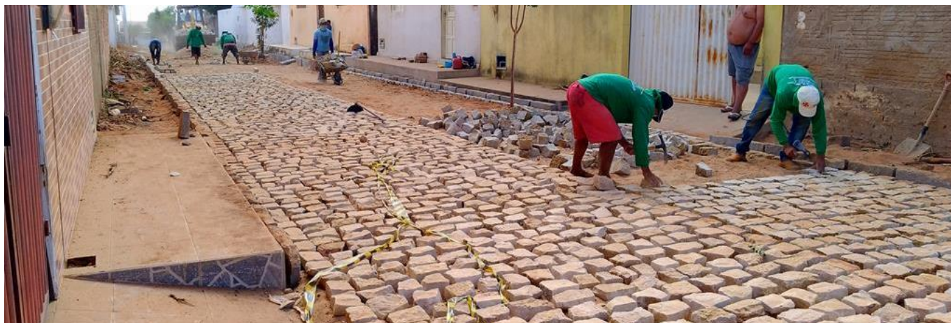
IMAGEM 05: ASSENTAMENTO DE PARALELEPÍPEDOS
