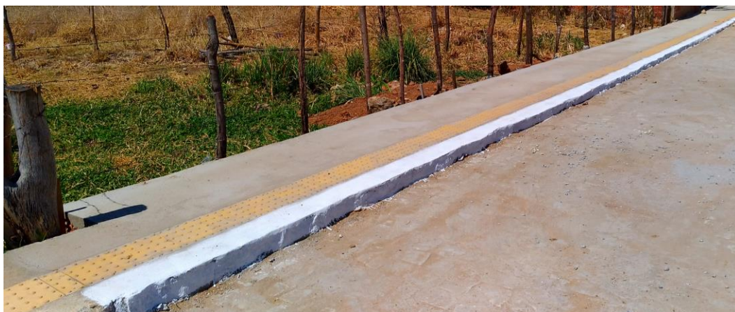
IMAGEM 09: PINTURA DE MEIO FIO.
