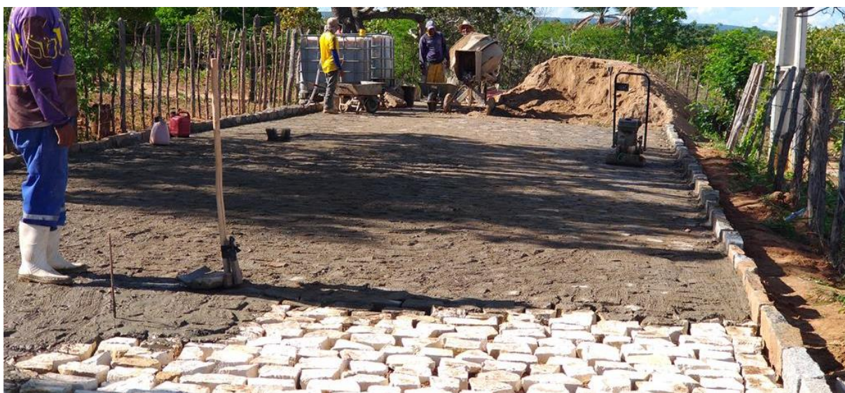
IMAGEM 06: REJUNTAMENTO DE PARALELEPÍPEDOS
