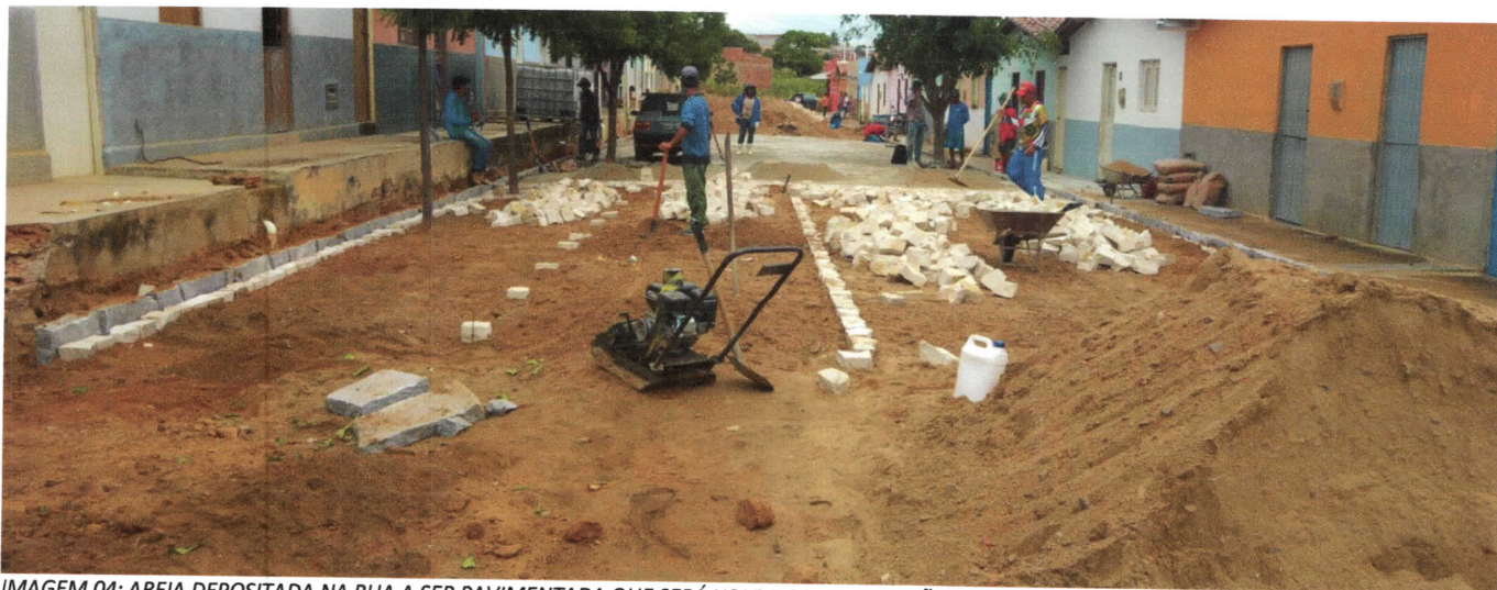
IMAGEM 04: AREIA DEPOSITADA NA RUA A SER PAVIMENTADA QUE SERÁ USADA COMO COLCHÃO DE AREIA
