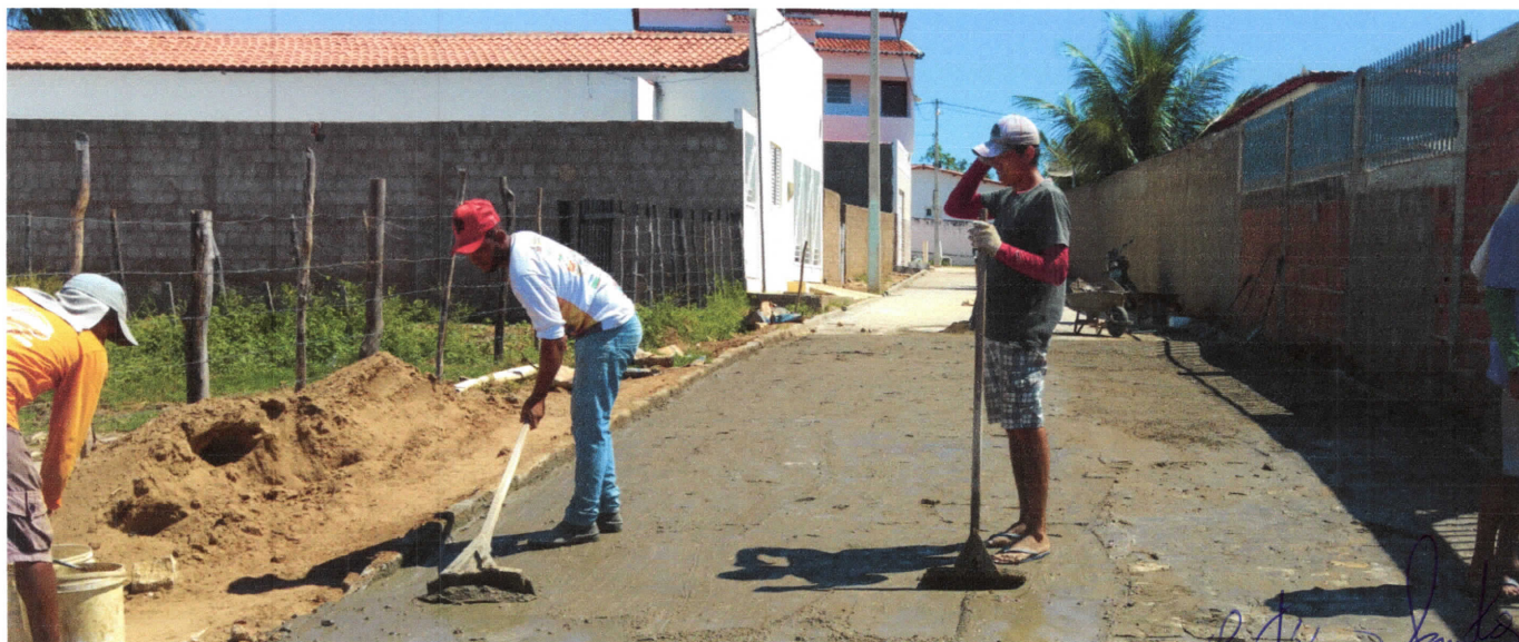
IMAGEM 07: COMPACTAÇÃO MANUAL DO PAVIMENTO
