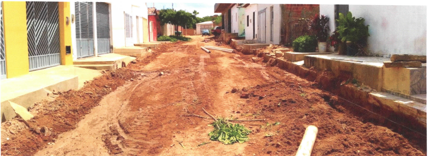
IMAGEM 02: TERRENO COM TERRAPLANAGEM EXECUTADA
