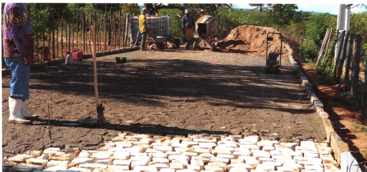
IMAGEM 06: REJUNTAMENTO DE PARALELEPÍPEDOS
