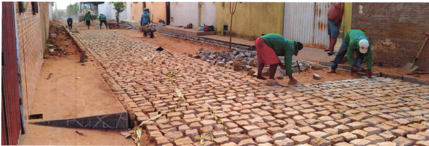
IMAGEM 05: ASSENTAMENTO DE PARALELEPÍPEDOS
