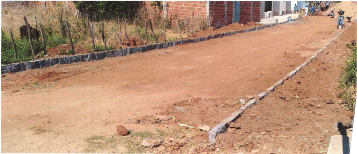
IMAGEM 03: EXECUÇÃO DE MEIO-FIO
