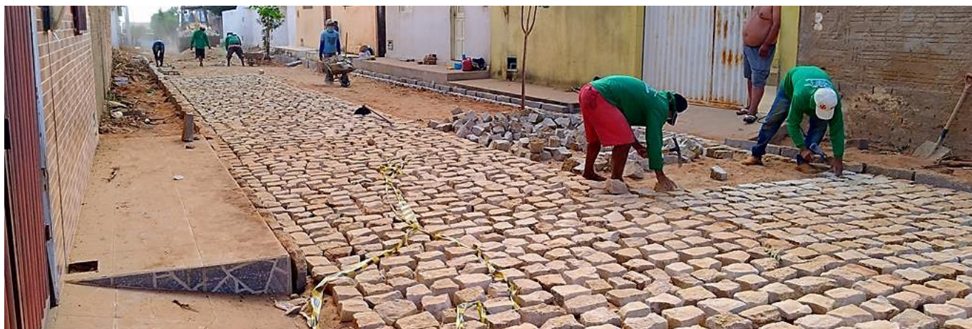
IMAGEM 04: ASSENTAMENTO DE PARALELEPÍPEDOS
