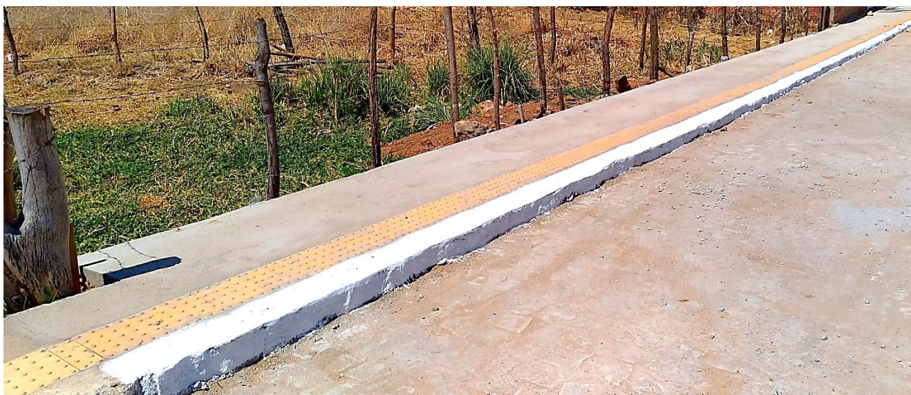
IMAGEM 08: PINTURA DE MEIO FIO.
