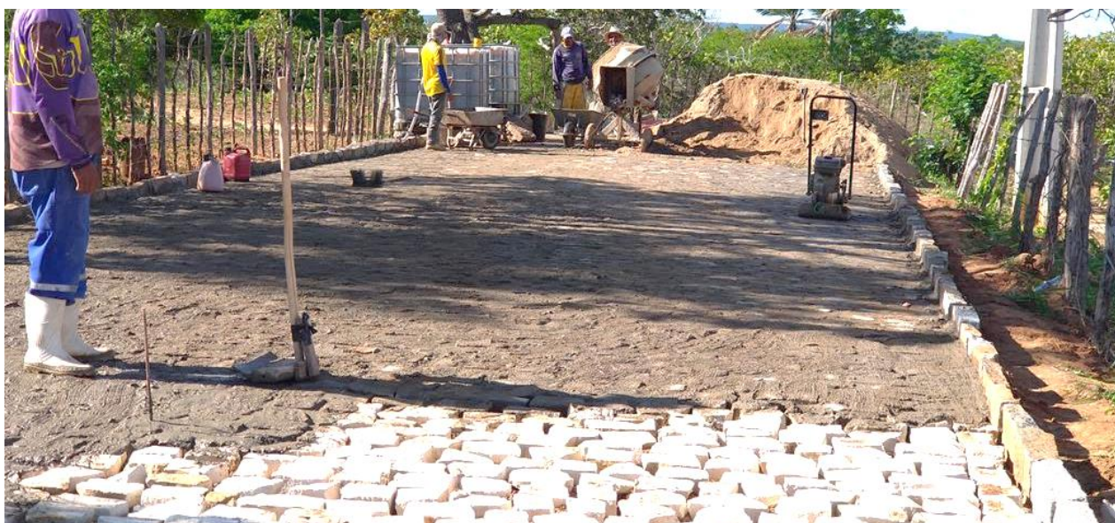
IMAGEM 05: REJUNTAMENTO DE PARALELEPÍPEDOS
