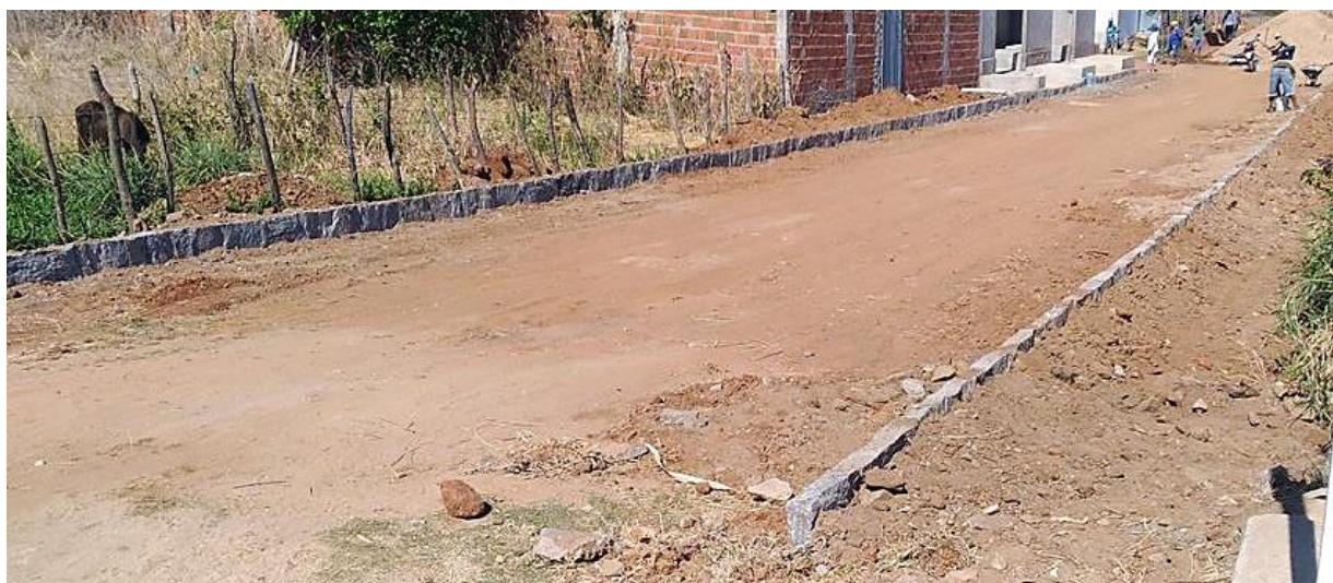
IMAGEM 04: EXECUÇÃO DE MEIO-FIO
