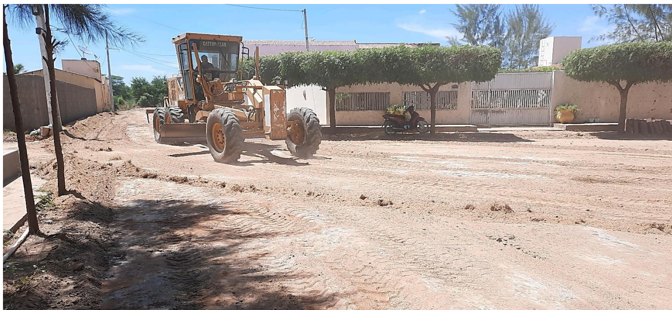
IMAGEM 03: EXECUÇÃO DA TERRAPLANAGEM DE RUA
