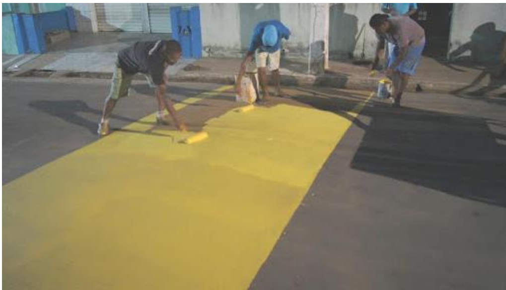
IMAGEM 09: PINTURA DE MEIO FIO.
