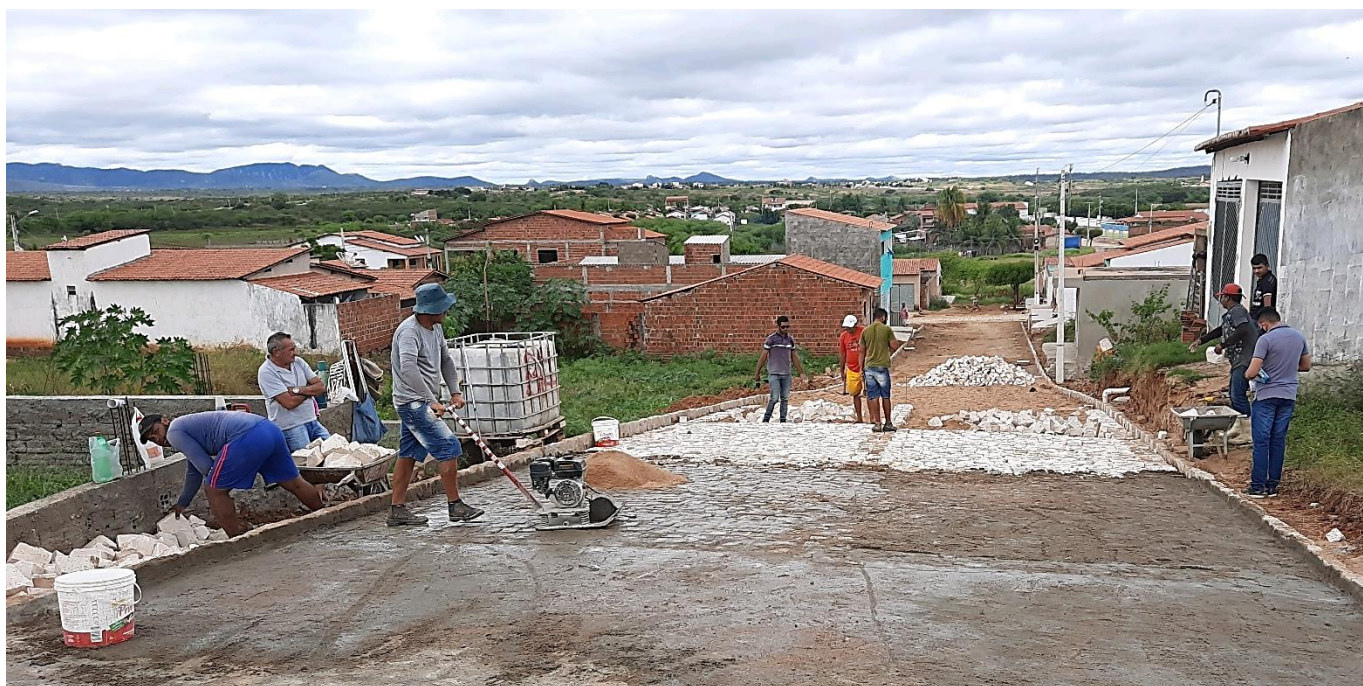
IMAGEM 06: COMPACTAÇÃO MANUAL DO PAVIMENTO
