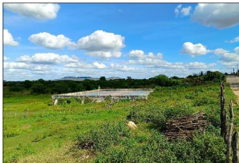
Foto 5 - Contexto da quadra objeto de proposta para reforma, localizada na Rua Maura Germano, Bairro Bela Vista, Major Sales/RN. 11/06/24.
